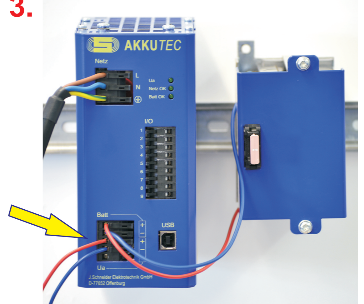
Anschluss der Last an den gepufferten 24VDC Ausgang des AKKUTEK
